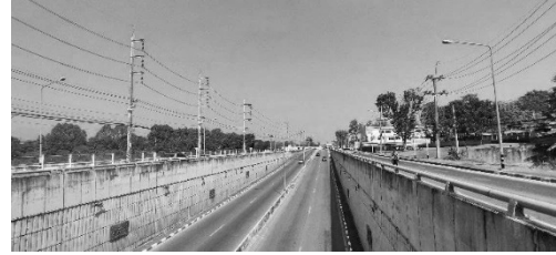
ทองลอดดอนแก้ว จุดตัด ทล.107
