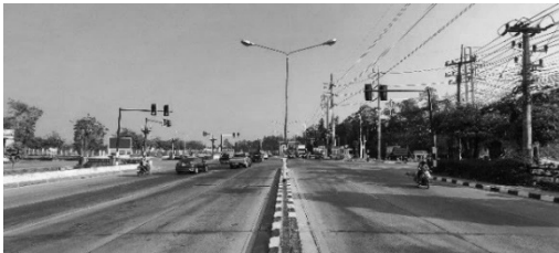
จุดตัด ทล.1366 กม.38+050
