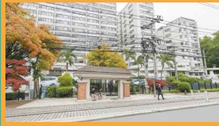
การวางตำแหน่งอาคารจอดรถโดยสาร บริเวณกม.39+700
