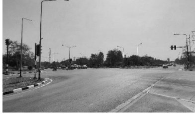
จุดเริ่มต้นโครงการ กม.32+000 (แยกดอนแก้ว)
