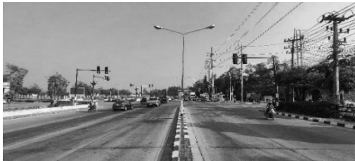
จุดตัด ทล.1366 กม.38+050
