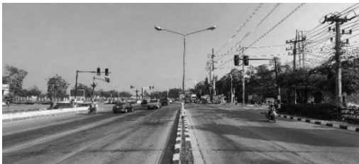
จุดตัด ทล.1366 กม.38+050
