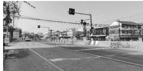
ถนนเจ็ดยอด-ช้างเคียน กม.39+670
